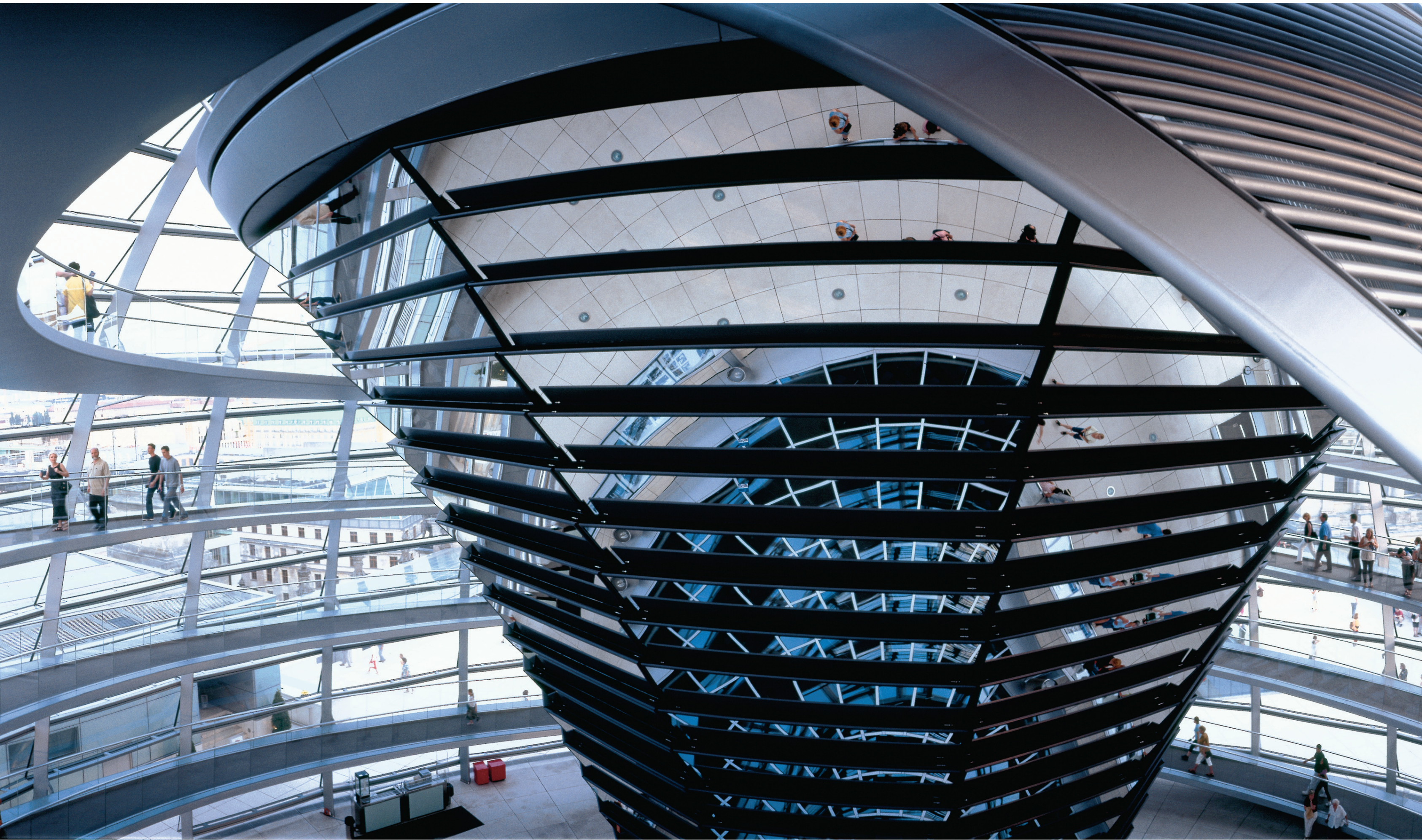
Die Umlenkspiegel reflektieren das Sonnenlicht aus der „Kuppel der Nation“ in den Plenarsaal des Reichstagsgebäudes
